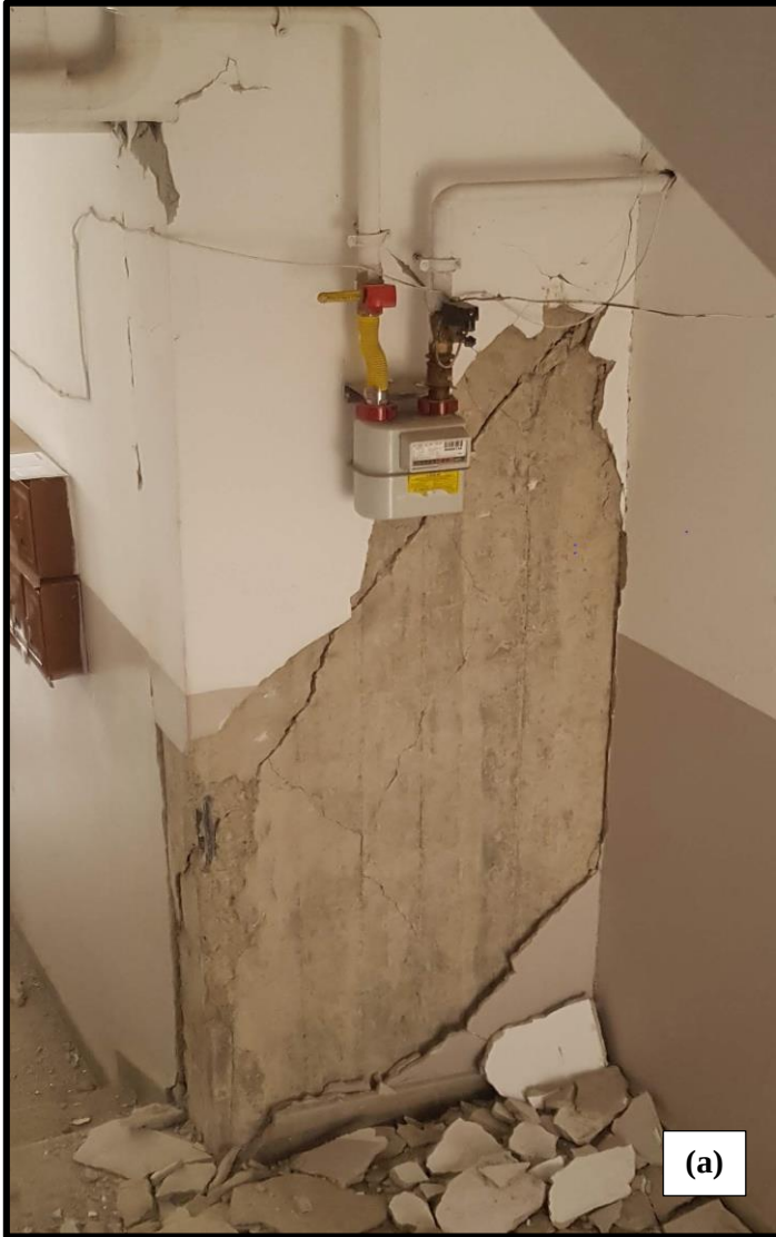
Şekil 4.68 a) Kesme hasarı meydana gelmiş kolon, b) Kesme çatlağı genişliği, c) Boyuna donatıda burkulma
