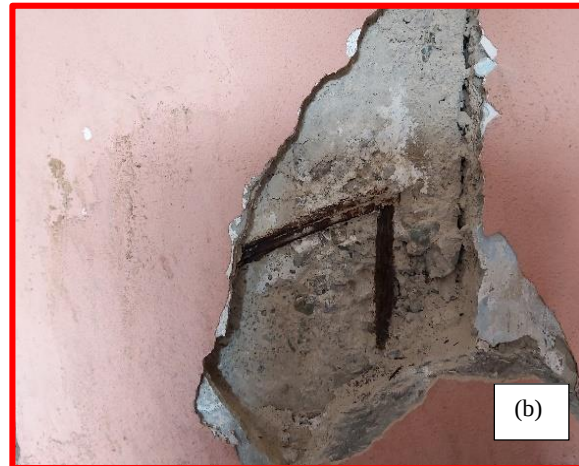
Şekil 4.78 Donatısında korozyon gözlenen kolon
