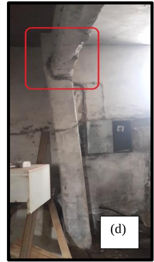
Şekil 4.107 Zemin kat kolon hasarı ve filiz donatısı ile enine donatı detayı
