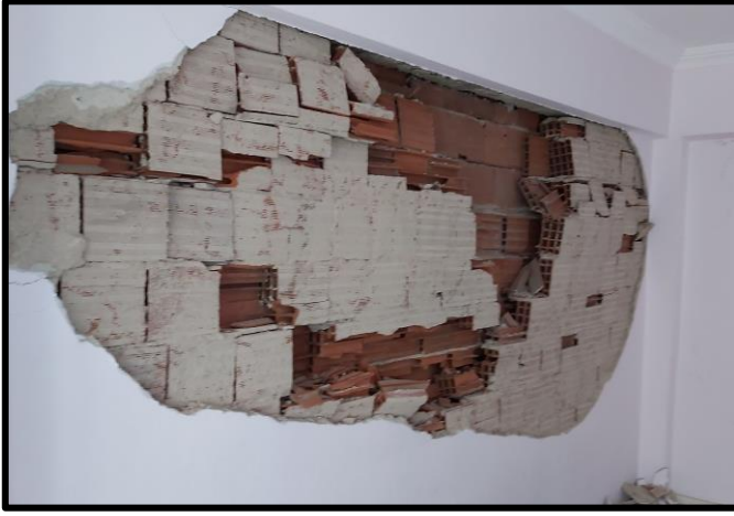
Şekil 4.10 Çekiçleme etkisi ile meydana gelen hasar
