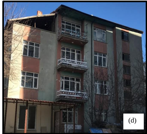
Şekil 5.1 Harman tuğlası ve düşey delikli tuğla kullanılarak inşa edilen yığma binalar
