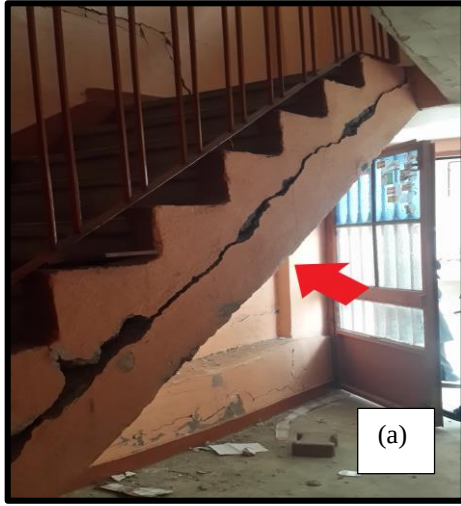
Şekil 4.105 Merdiven hasarı ve detayı
