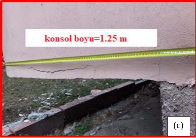
Şekil 4.41 Kapalı çıkma hasarı ve tasarım detayı
