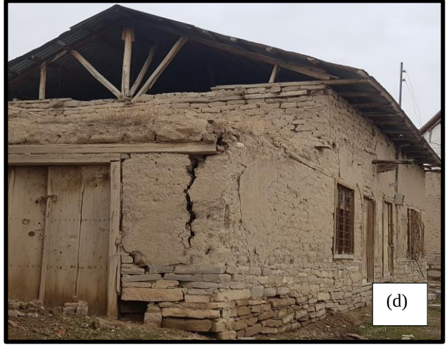
Şekil 5.9 Tadım Köyü'nde gözlenen kerpiç yığma bina hasarları
