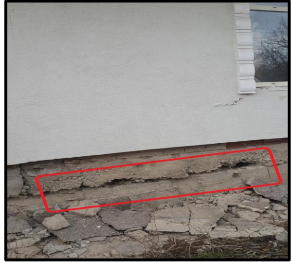
Şekil 4.104 Temel ile zemin kat döşemesinin birleşimi
