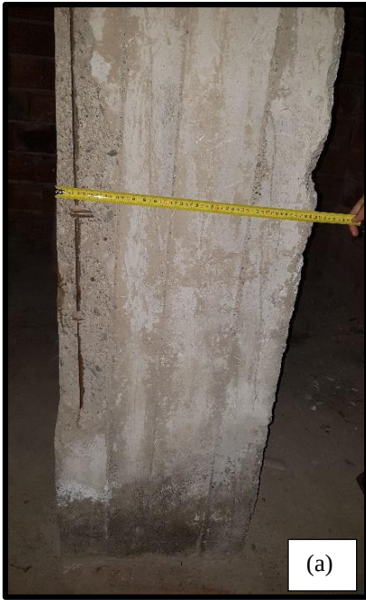
Şekil 4.113 Bodrum kat kolonu ve donatı düzenleme detayları
