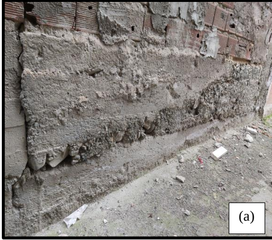
Şekil 4.56 Kısmi bodrumlu binada temel ile bodrum perdesinin birleşim detayı
