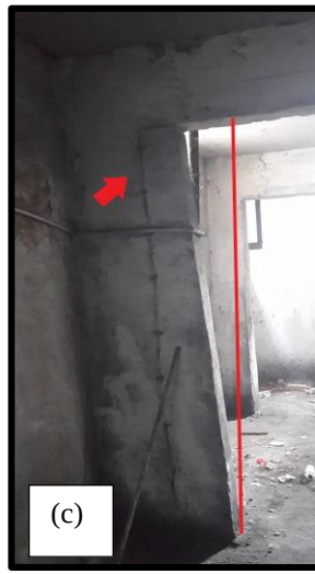
Şekil 4.108 Bodrum kat kolonlarında gözlenen işçilik kusurları
