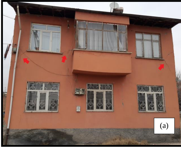
Şekil 5.3 Tuğla yığma binalarda gözlenen deprem hasarları
