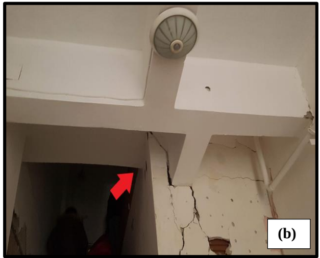
Şekil 4.99 Deprem hasarı, a) dolgu duvar b) hatalı tali kiriş birleşimi ve dolgu duvar
