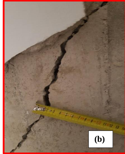
Şekil 4.67 Zemin kat hasar görüntüleri a) dolgu duvar hasarı, b) kolonda kesme hasarı
