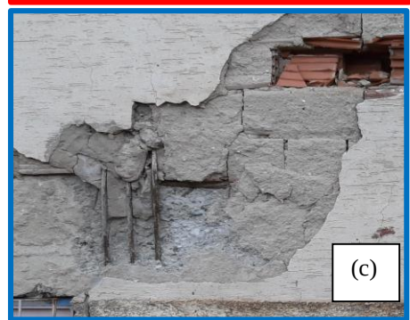
Şekil 4.29 Binanın kolon-kiriş birleşim bölgesi hasar gören dış aksı ve hasar detayları
