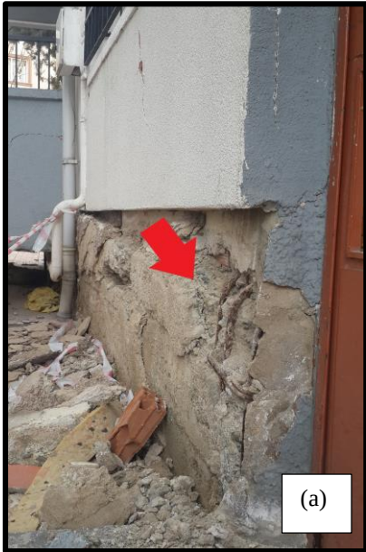
Şekil 4.106 Zemin kat kolonlarında gözlenen nem problemi
