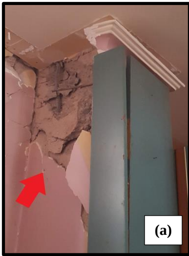
Şekil 4.92 Kesme hasarı gözlenen zemin kat kolon detayı a) hasar durumu, b) enine donatı aralığı, c) boyuna donatı hasar durumu ve enine donatı kanca detayı
