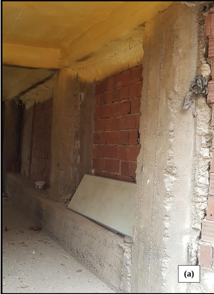
Şekil 4.66 Zemin kat seviyesinde komşu bina ile ortak kullanılan temel
