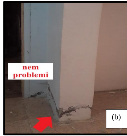
Şekil 4.106 Zemin kat kolonlarında gözlenen nem problemi
