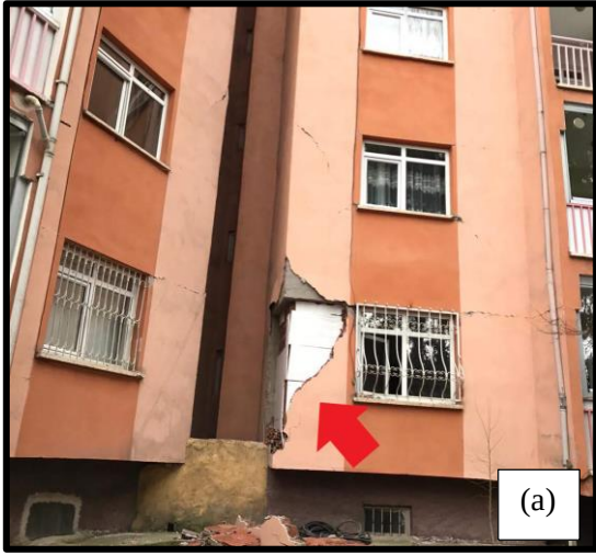
Şekil 4.43 Dış cephe dolgu duvar hasarı
