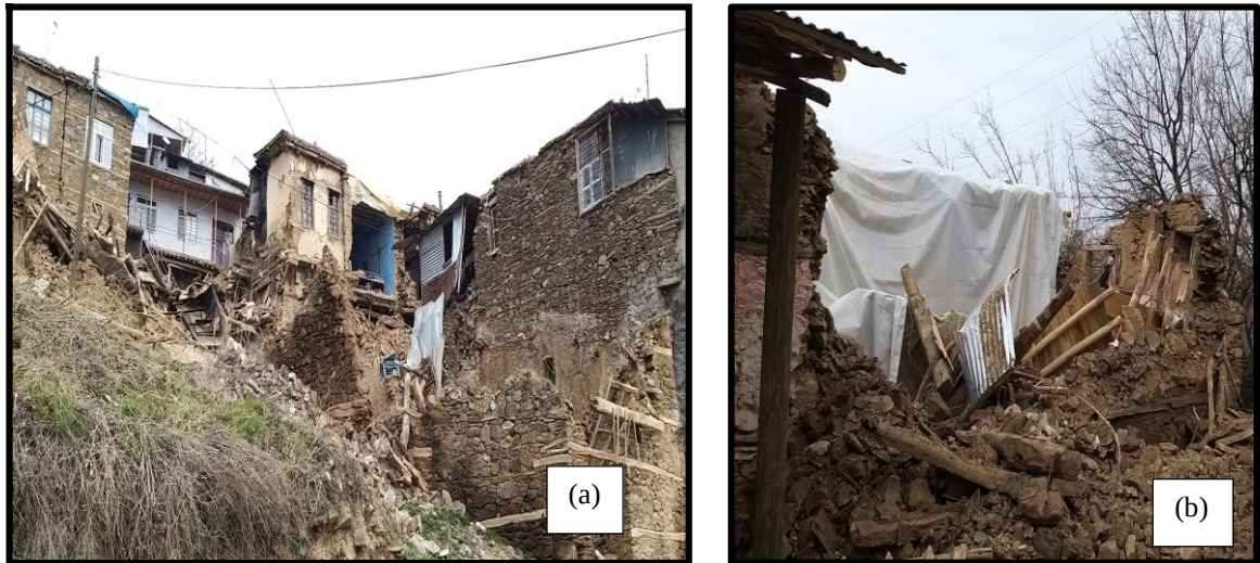
Şekil 5.6 Çevrimtaş Köyü'nde hasar gören binalar
