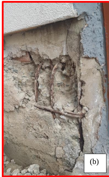
Şekil 4.106 Zemin kat kolonlarında gözlenen nem problemi
