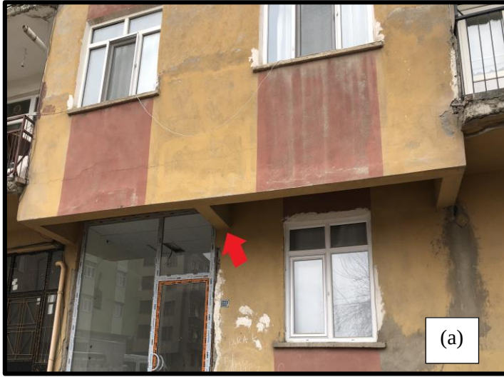
Şekil 4.55 Kapalı çıkma konsol kirişinde oluşan hasar
