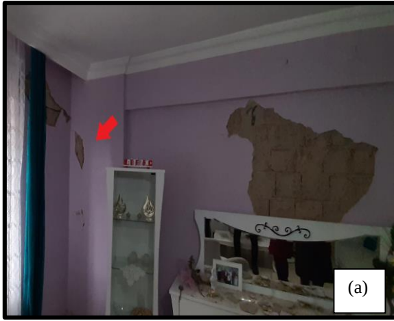
Şekil 4.24 Deprem hasarları, a) dolgu duvar hasarı, b) giriş kesme hasarı
