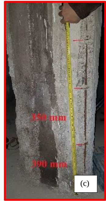
Şekil 4.113 Bodrum kat kolonu ve donatı düzenleme detayları
