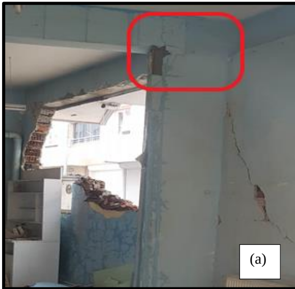
Şekil 4.60 Hasar resimleri a) zemin kat kolonunda eğilme hasarı başlanıcı b) merdiven plağı ile basamak arasında ayrılma
