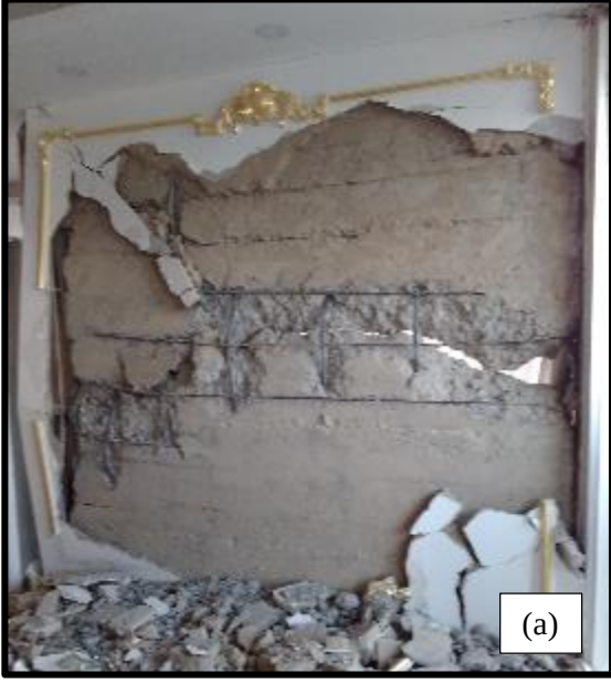
Şekil 4.89 Deprem perdesi hasar görüntüsü
