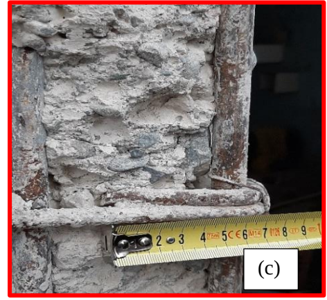
Şekil 4.59 Hasar gören zemin kat kolonu ve enine donatı düzenleme detayları
