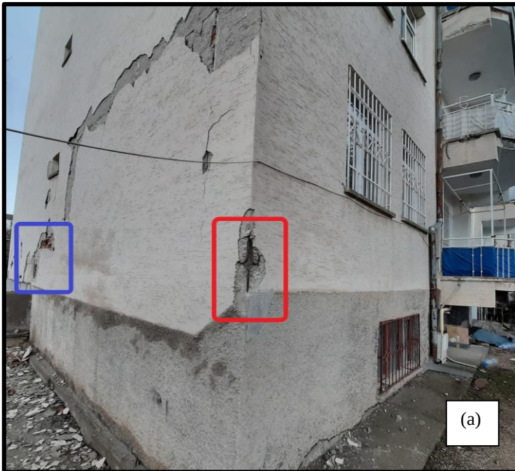
Şekil 4.29 Binanın kolon-kiriş birleşim bölgesi hasar gören dış aksı ve hasar detayları
