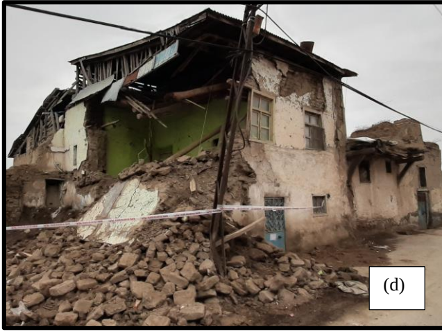
Şekil 5.4 Kerpiç yığma binalarda gözlenen deprem hasarları
