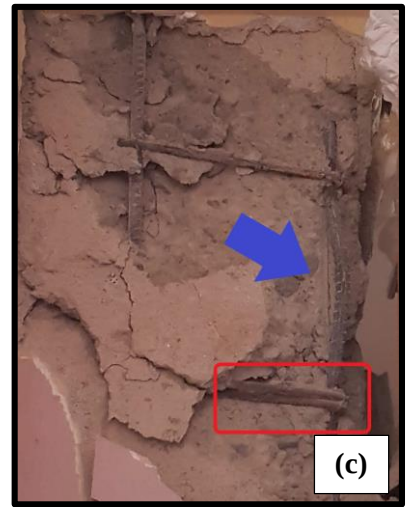
Şekil 4.92 Kesme hasarı gözlenen zemin kat kolon detayı a) hasar durumu, b) enine donatı aralığı, c) boyuna donatı hasar durumu ve enine donatı kanca detayı
