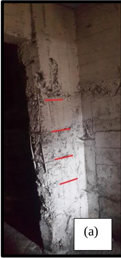
Şekil 4.107 Zemin kat kolon hasarı ve filiz donatısı ile enine donatı detayı
