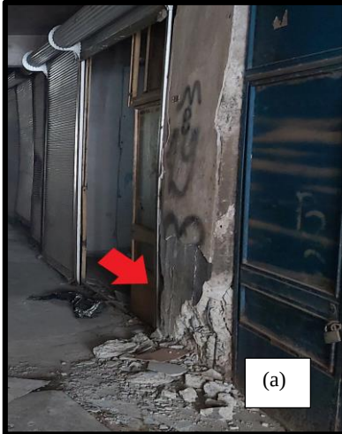
Şekil 4.74 Zemin kat kolon hasarları ve donatı düzenleme detayları
