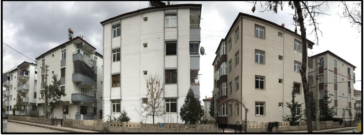
Şekil 4.102 Blokların dış cephe görüntüsü
