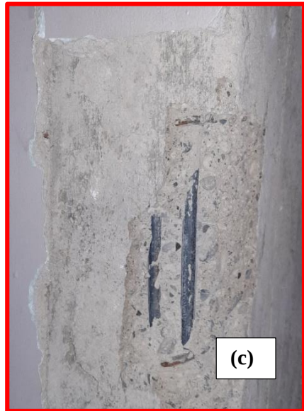
Şekil 4.68 a) Kesme hasarı meydana gelmiş kolon, b) Kesme çatlağı genişliği, c) Boyuna donatıda burkulma
