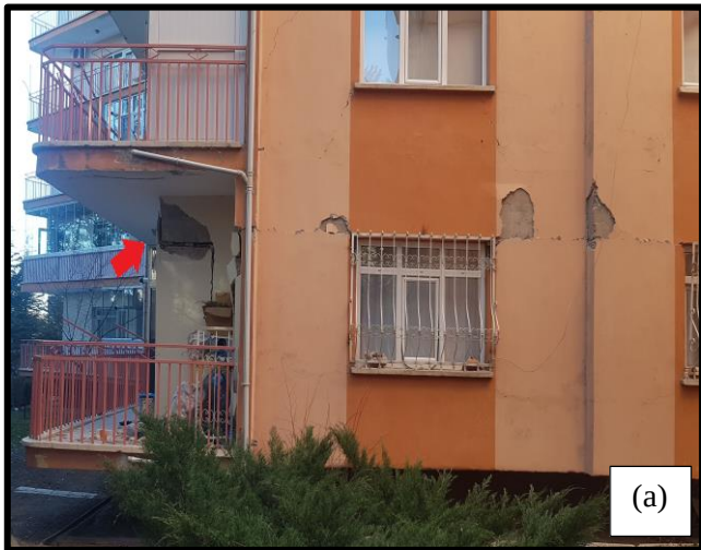
Şekil 4.42 Konsol balkon ve hasar detayı
