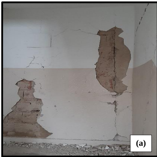
Şekil 4.96 Deprem hasarı a) dolgu duvar, b) merdiven plağı
