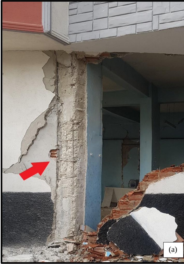
Şekil 4.59 Hasar gören zemin kat kolonu ve enine donatı düzenleme detayları
