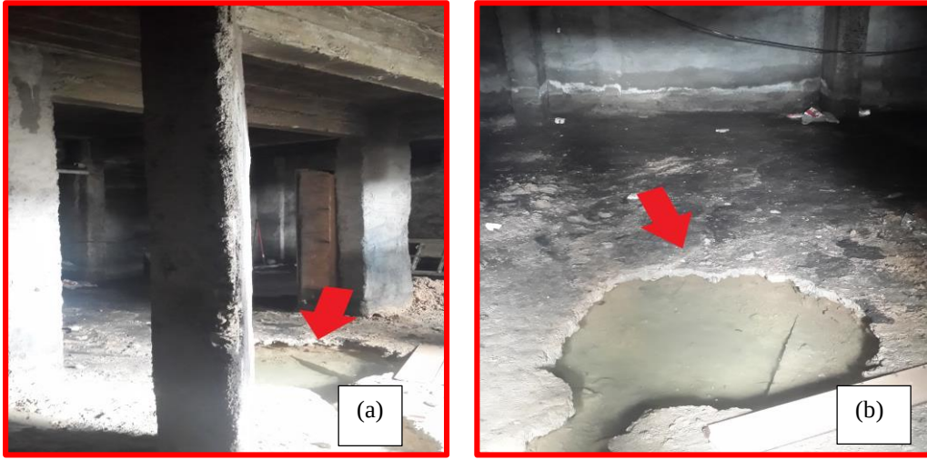
Şekil 4.125 Bodrum katta açılan ve içi su dolu olan çukur
