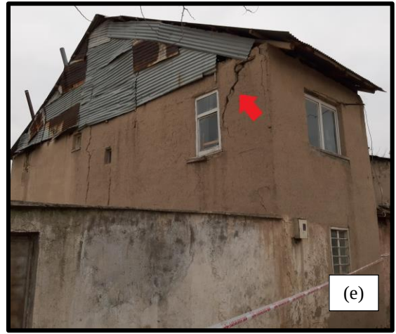
Şekil 5.4 Kerpiç yığma binalarda gözlenen deprem hasarları
