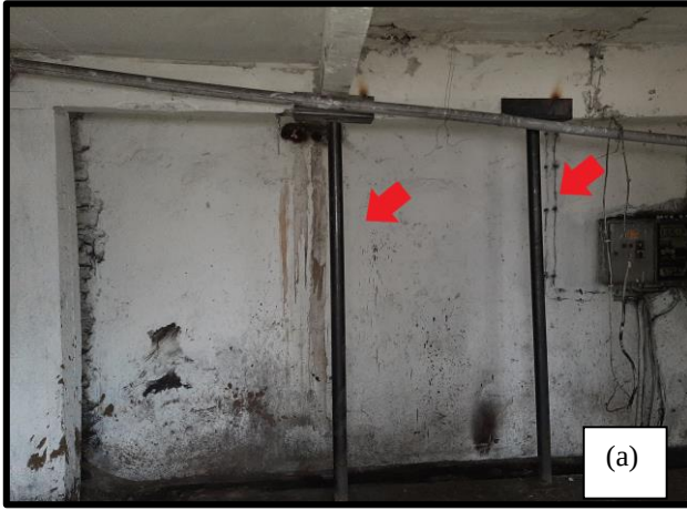
Şekil 4.26 Bodrum kat kirişlerinde yapılan güçlendirme uygulamaları
