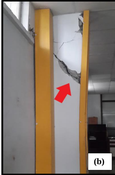
Şekil 4.98 Kesme hasarı gözlenen zemin kat kolonları
