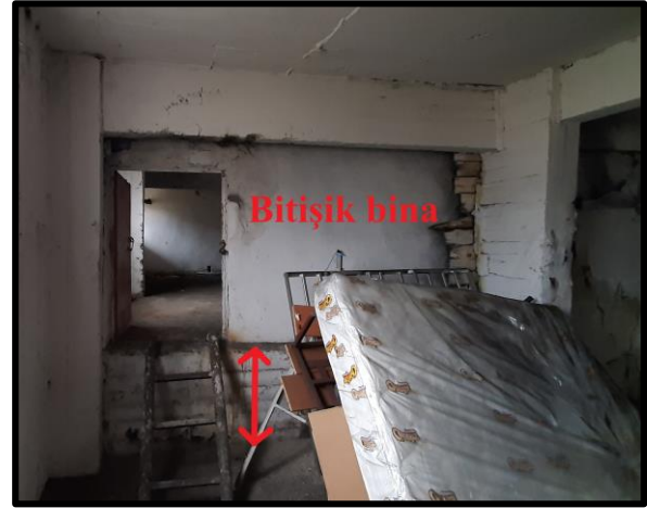
Şekil 4.28 Bodrum katta bloklar arası kot farkı
