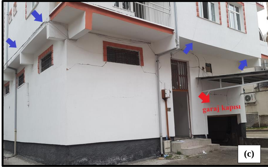
Şekil 4.97 Bina cephe görüntüleri
