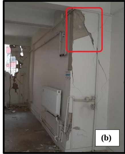
Şekil 4.67 Zemin kat hasar görüntüleri a) dolgu duvar hasarı, b) kolonda kesme hasarı
