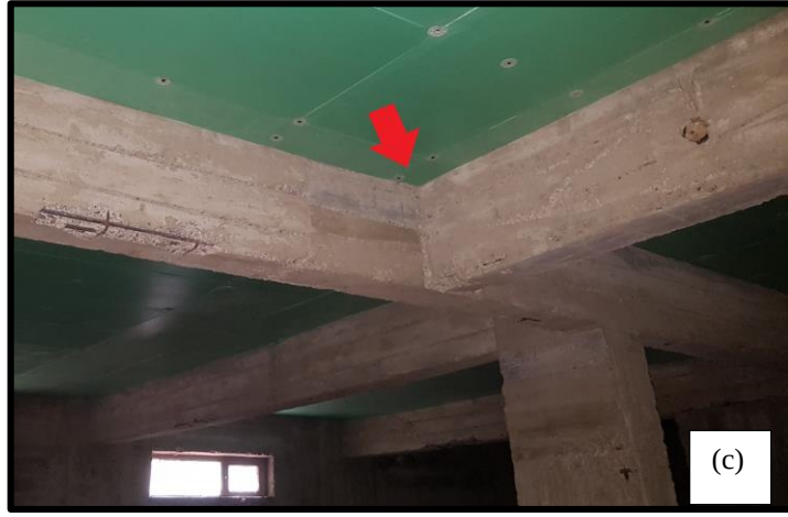
Şekil 4.114 Kiriş görüntüleri, a-b) kesme hasarı meydana gelen kiriş ve etriye detayı, c) tali kiriş mesnet detayı
