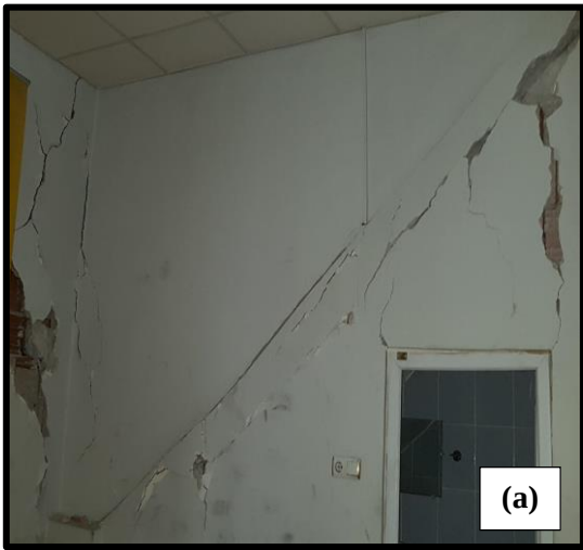
Şekil 4.99 Deprem hasarı, a) dolgu duvar b) hatalı tali kiriş birleşimi ve dolgu duvar
