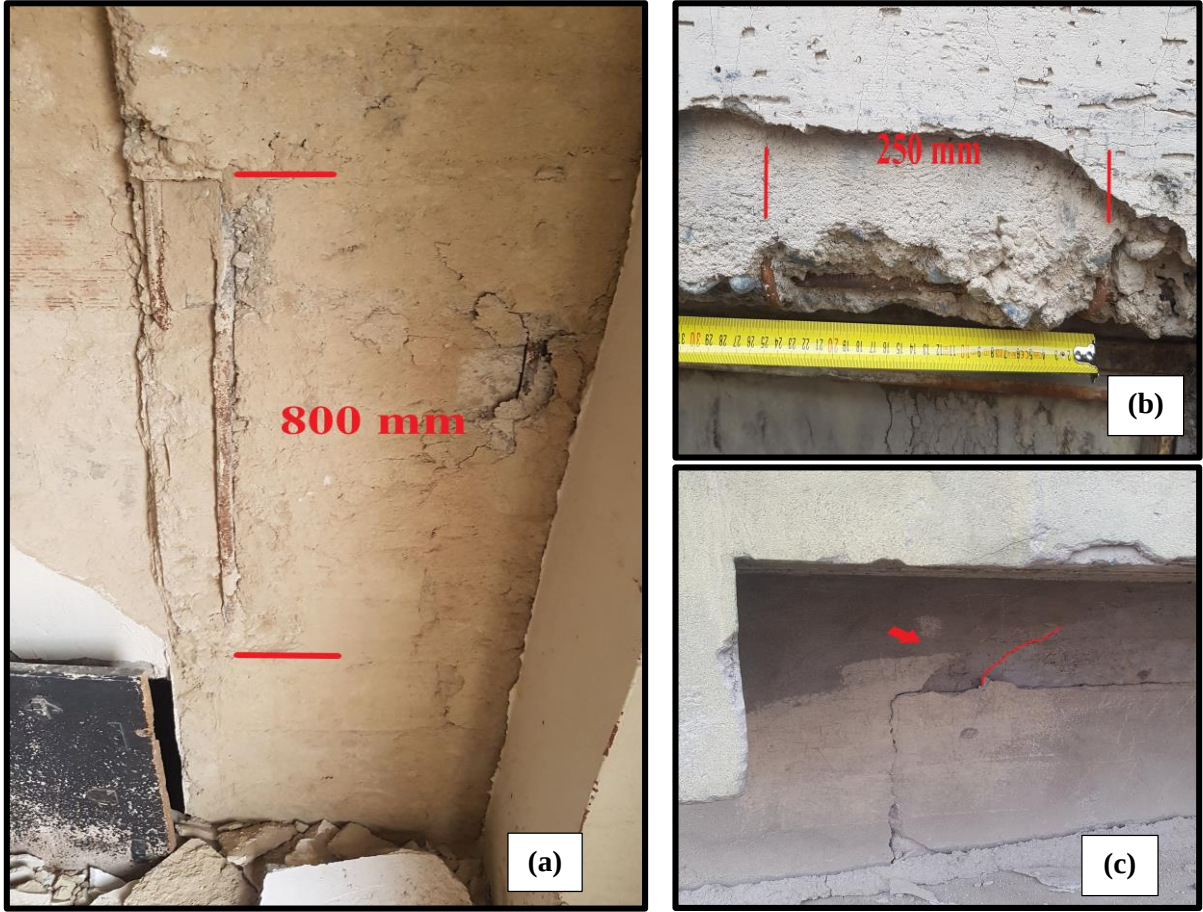
Şekil 4.72 Taşıyıcı eleman görüntüleri a) kolonda donatı düzenleme detayı, b) kirişte donatı düzenleme detayı, c) kirişte kesme hasarı
