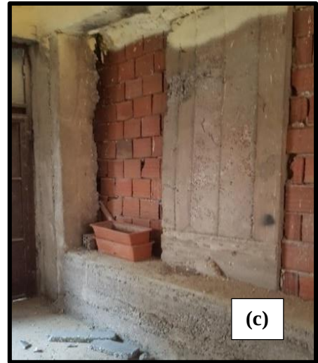
Şekil 4.66 Zemin kat seviyesinde komşu bina ile ortak kullanılan temel
