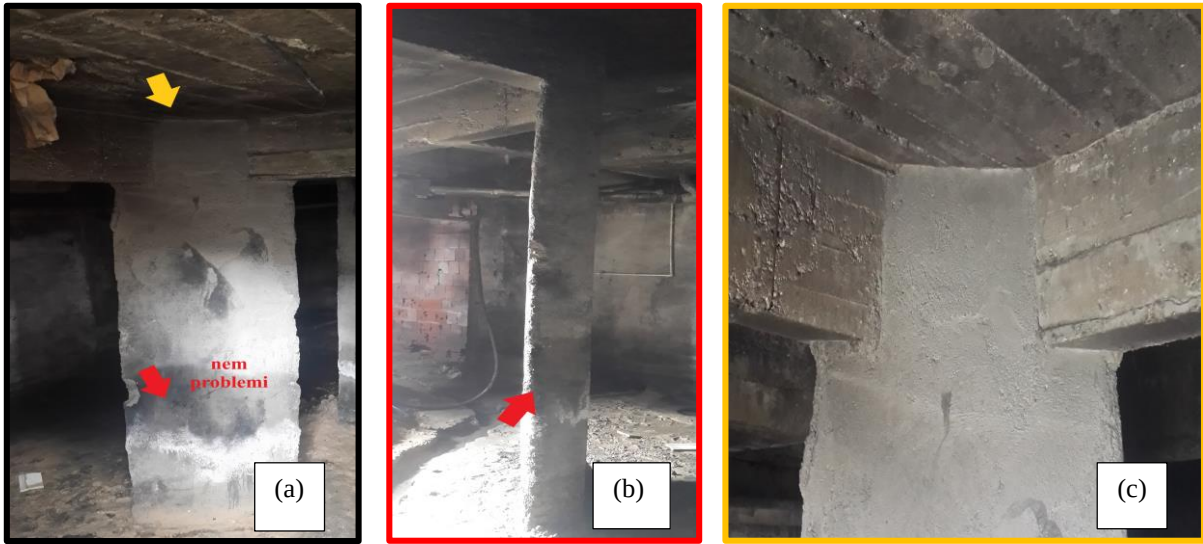
Şekil 4.126 Yamuk şeklinde plan geometrisine sahip kolon
