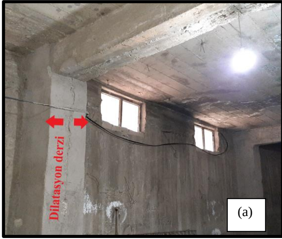
Şekil 4.23 İki blok arasında bırakılan dilatasyon derzi
