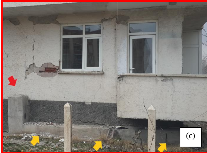
Şekil 4.118 Sitenin arka bloku güçlendirme imalatı
