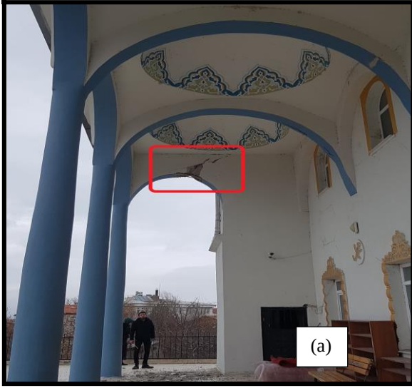
Şekil 4.132 Kemer kirişi ve hasar detayı
