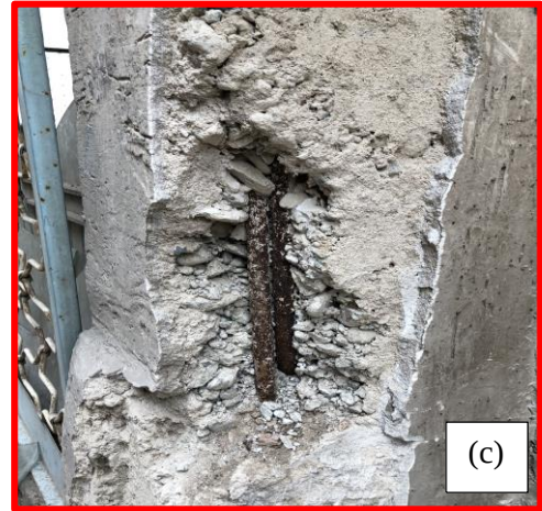
Şekil 4.50 Hasar gören zemin kat kolonu ve hasar detayları
