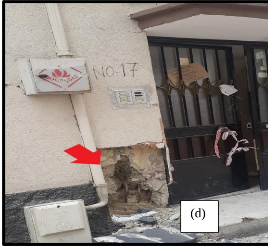
Şekil 4.107 Zemin kat kolon hasarı ve filiz donatısı ile enine donatı detayı
