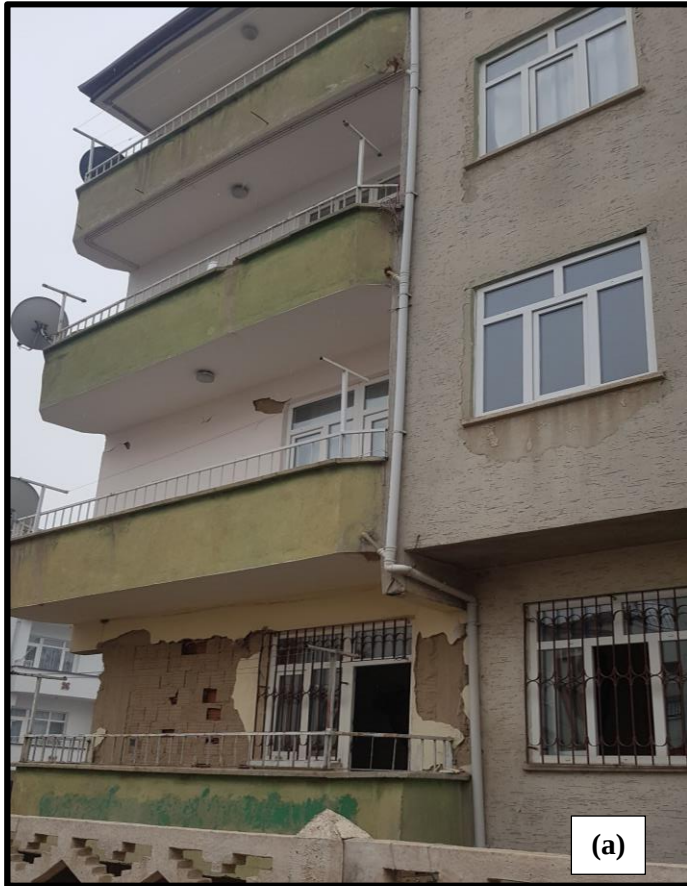
Şekil 4.71 Deprem hasarı görüntüleri a) dış cephe, b-c) dolgu duvar hasarı
