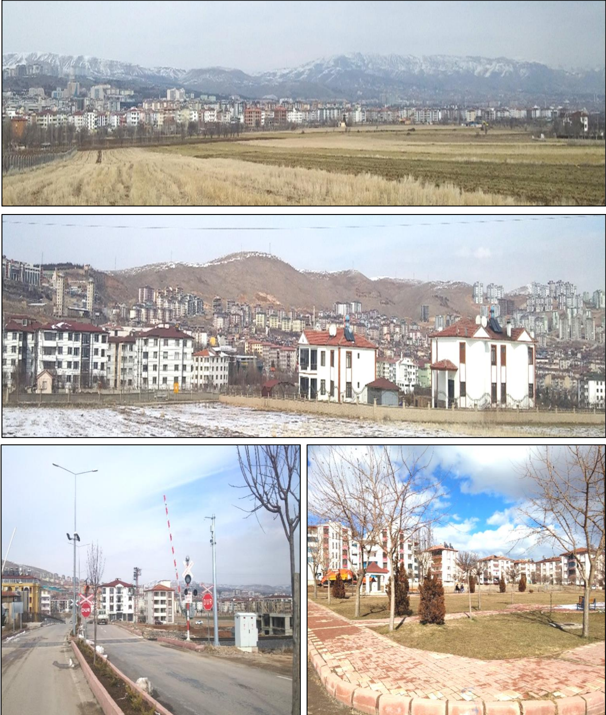
Şekil 2.7 Ataşehir Mahallesi bina stokundan görüntüler
