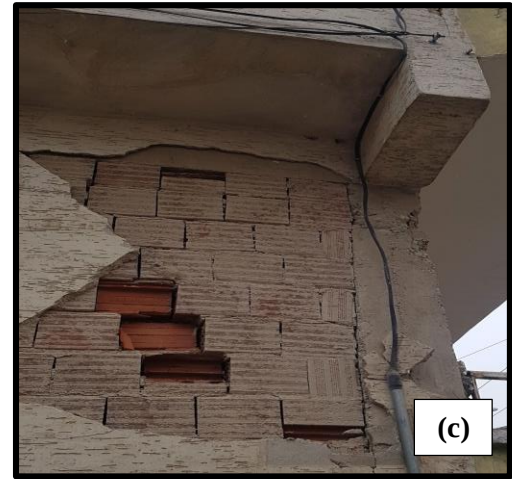
Şekil 4.71 Deprem hasarı görüntüleri a) dış cephe, b-c) dolgu duvar hasarı
