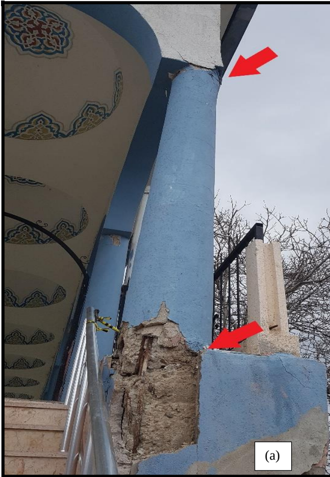
Şekil 4.129 Cami giriş cephesi kolonu ve hasar detayları
