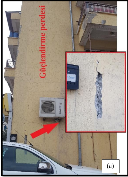
Şekil 4.135 Güçlendirme perdelerinde meydana gelen hasarlar
