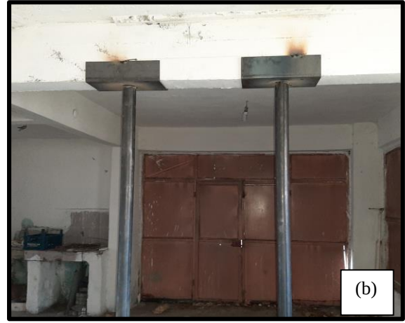
Şekil 4.26 Bodrum kat kirişlerinde yapılan güçlendirme uygulamaları
