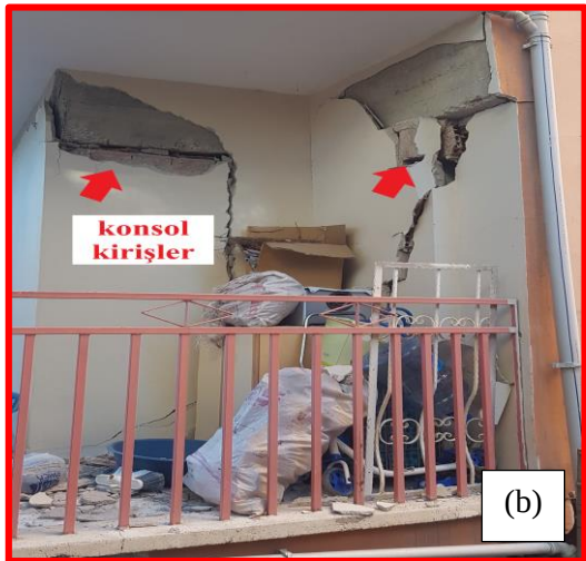
Şekil 4.42 Konsol balkon ve hasar detayı
