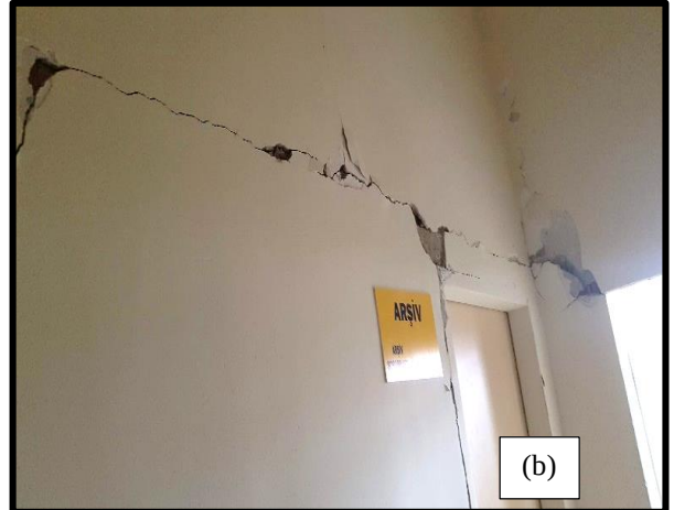
Şekil 4.135 Güçlendirme perdelerinde meydana gelen hasarlar
