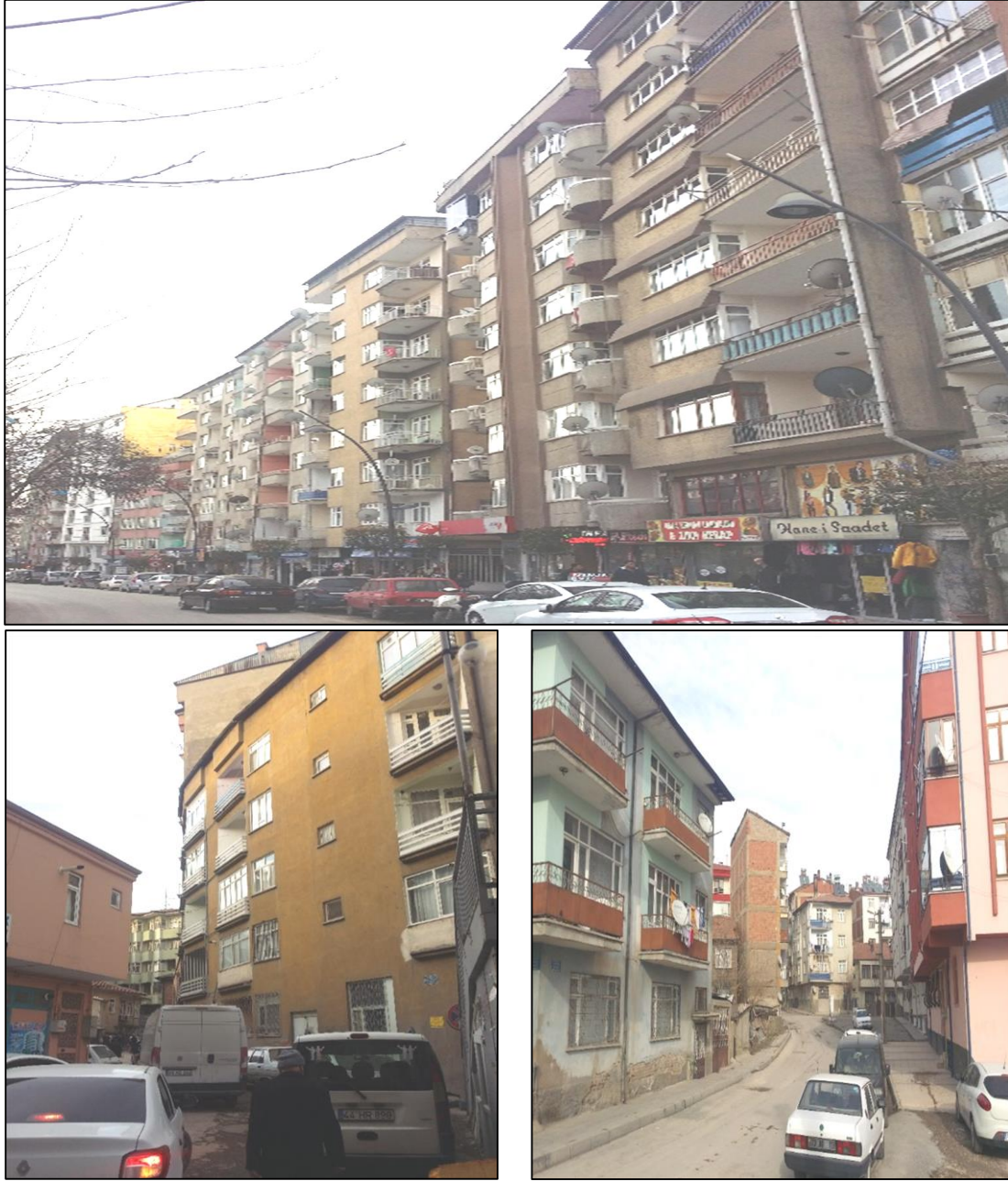
Şekil 2.5 Akpınar Mahallesi bina stokundan görüntüler
