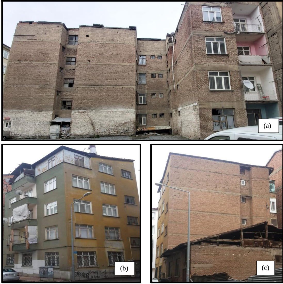
Şekil 5.2 Çok katlı yığma binalar, (a) Nailbey Mah.'nde bulunan yığma binanın arka cephesi, b-c) İzzetpaşa Mah.'nde bulunan yığma binanın sırasıyla ön ve arka cephesi
