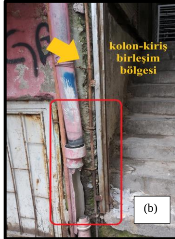
Şekil 4.74 Zemin kat kolon hasarları ve donatı düzenleme detayları
