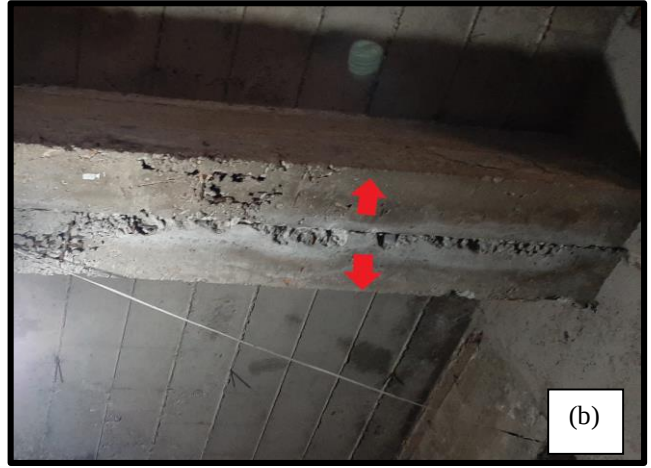
Şekil 4.23 İki blok arasında bırakılan dilatasyon derzi
