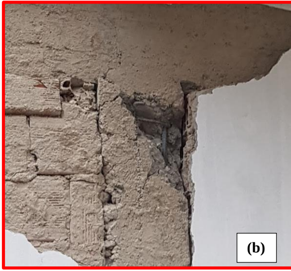
Şekil 4.91 Bina arka cephe kolonlarında meydana gelen kesme hasarları
