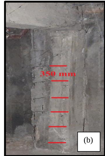
Şekil 4.34 Binanın taşıyıcı sistem elemanları ve kolon için etriye aralığı
