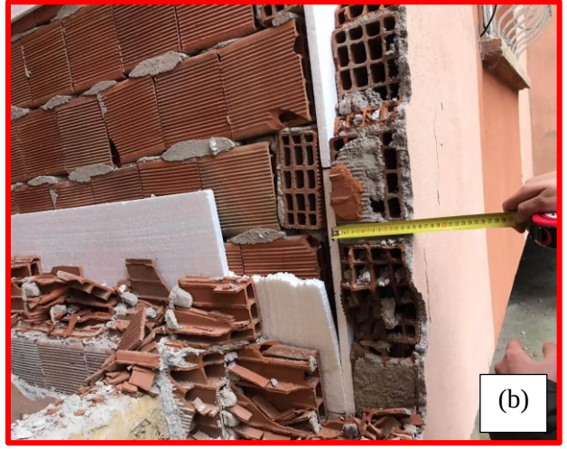
Şekil 4.43 Dış cephe dolgu duvar hasarı
