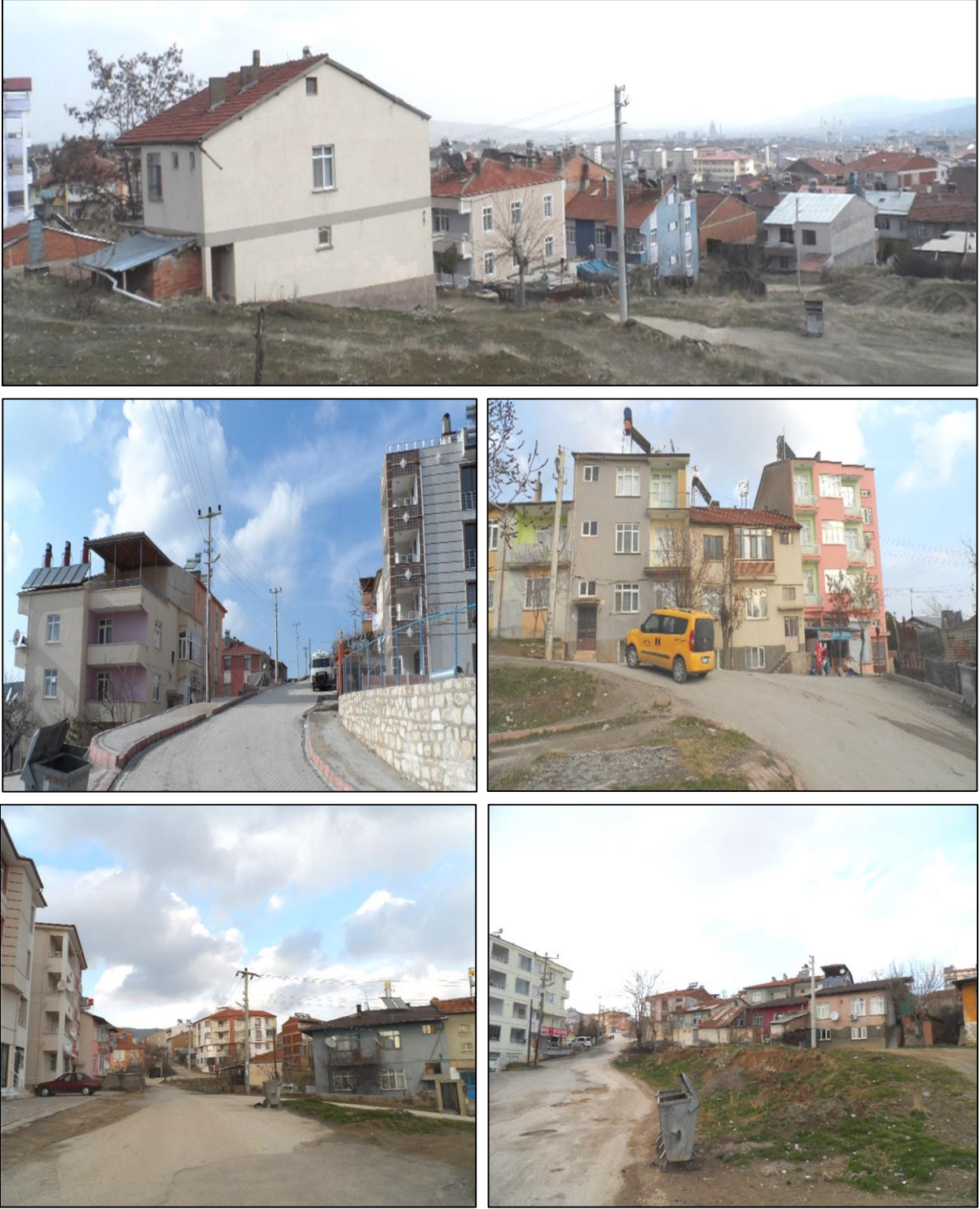
Şekil 2.13 Esentepe Mahallesi bina stokundan görüntüler
