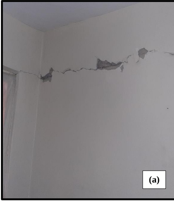
Şekil 4.70 a) Dolgu duvar hasarı, b) Donatısı açıkta olan kolon-kiriş birleşim bölgesi
