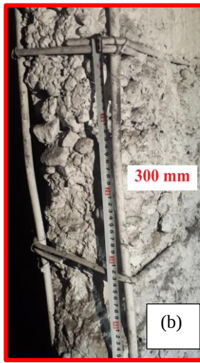
Şekil 4.108 Bodrum kat kolonlarında gözlenen işçilik kusurları
