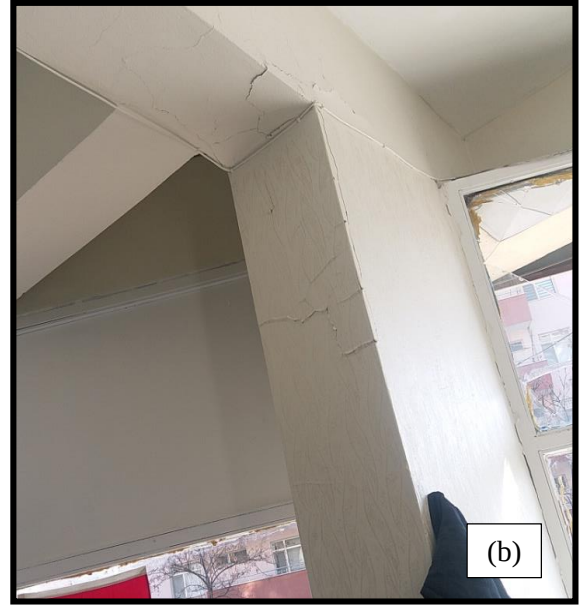
Şekil 4.86 Yaygın hasar gözlenen kirişler ve kolonlar
