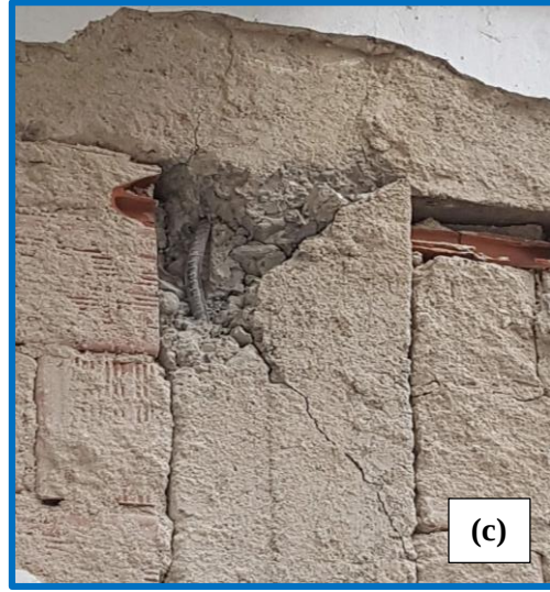
Şekil 4.91 Bina arka cephe kolonlarında meydana gelen kesme hasarları
