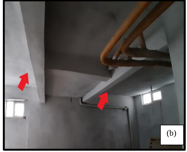
Şekil 4.37 Betonarme kiriş ve döşeme, a) sehim gözlenen döşeme ve hasar gören kiriş, b) tali kiriş ile ana kiriş birleşimi
