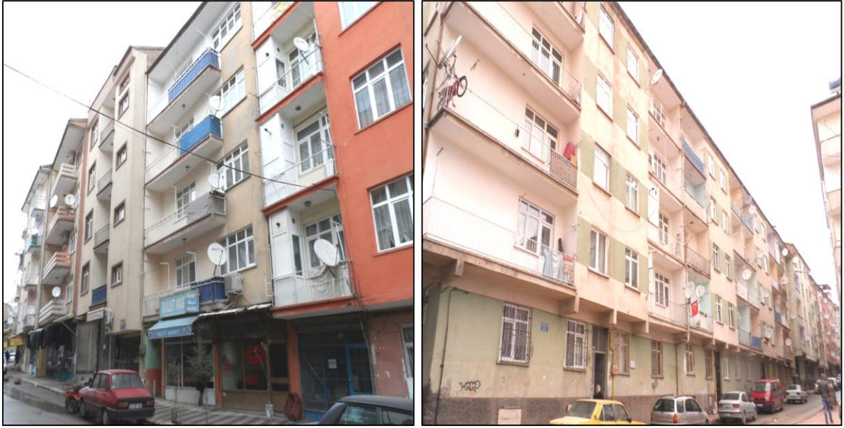
Şekil 2.31 Sarayatık Mahallesi bina stokundan görüntüler
