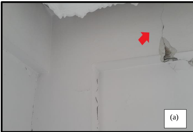
Şekil 4.109 Çerçeve kirişinde gözlenen kesme çatlağı
