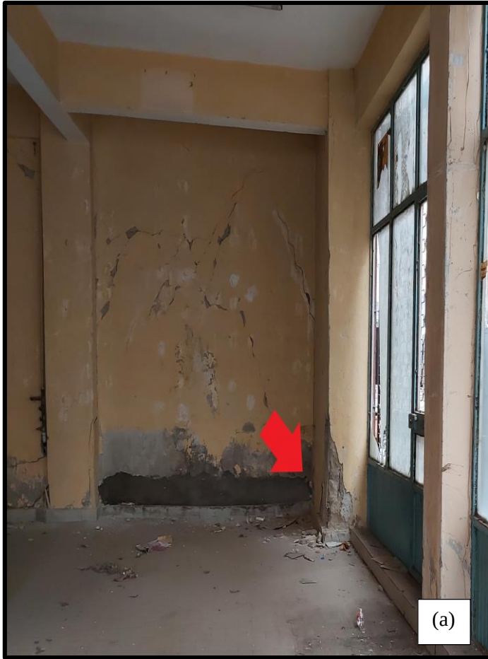
Şekil 4.50 Hasar gören zemin kat kolonu ve hasar detayları
