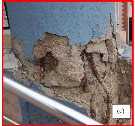
Şekil 4.129 Cami giriş cephesi kolonu ve hasar detayları
