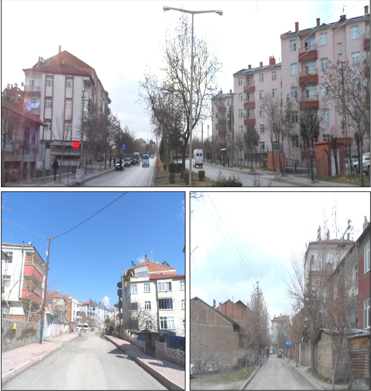
Şekil 2.21 Kırklar Mahallesi bina stokundan görüntüler
