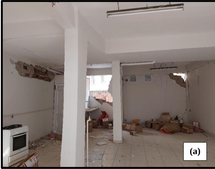
Şekil 4.67 Zemin kat hasar görüntüleri a) dolgu duvar hasarı, b) kolonda kesme hasarı
