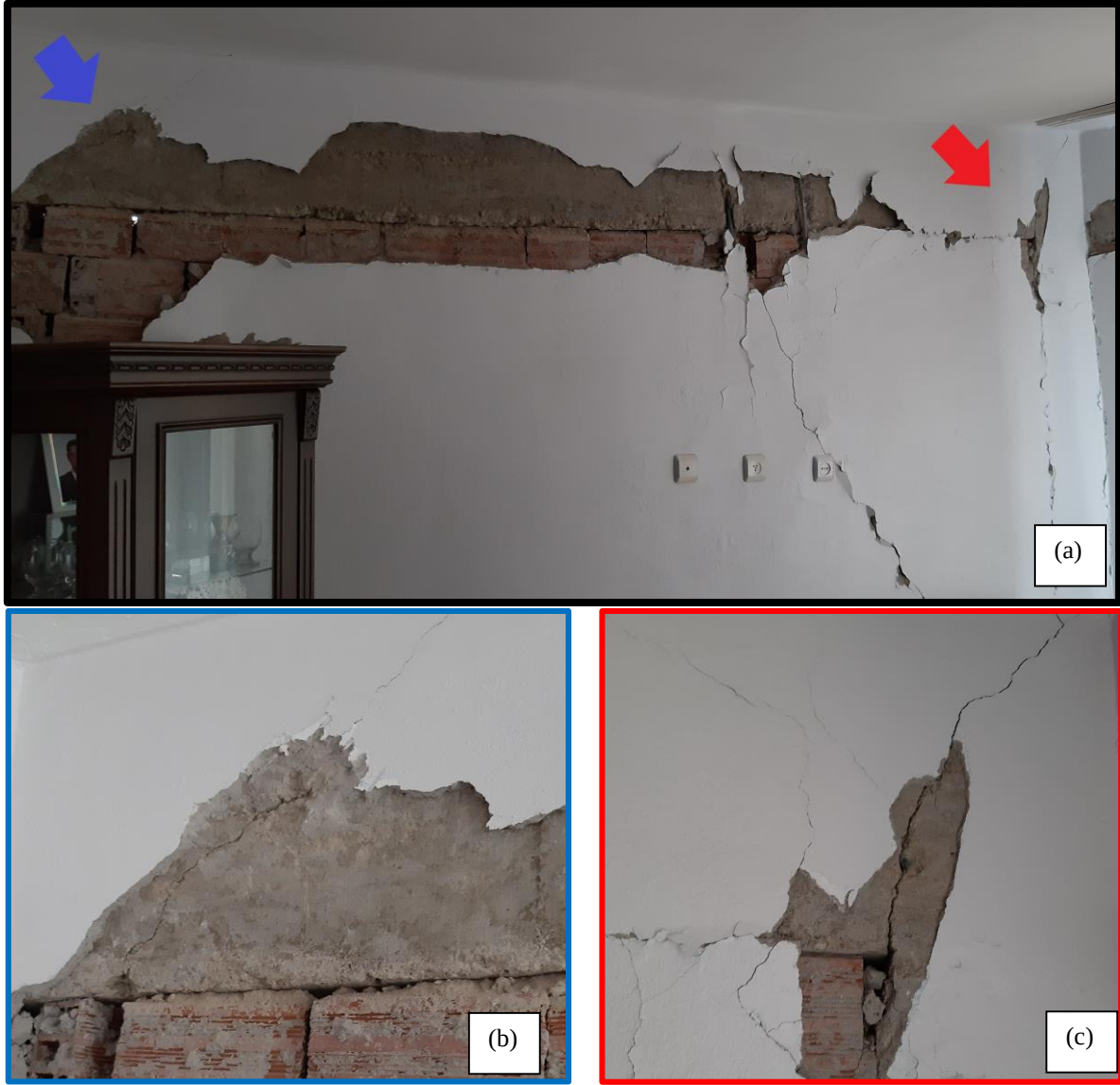
Şekil 4.35 Çerçeve kirişi ve hasar detayları
