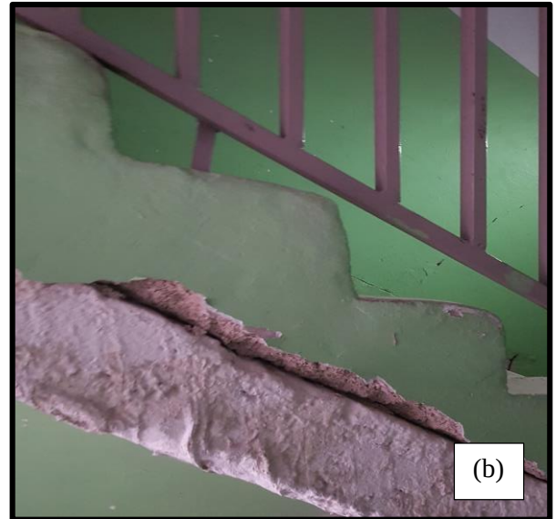
Şekil 4.60 Hasar resimleri a) zemin kat kolonunda eğilme hasarı başlanıcı b) merdiven plağı ile basamak arasında ayrılma
