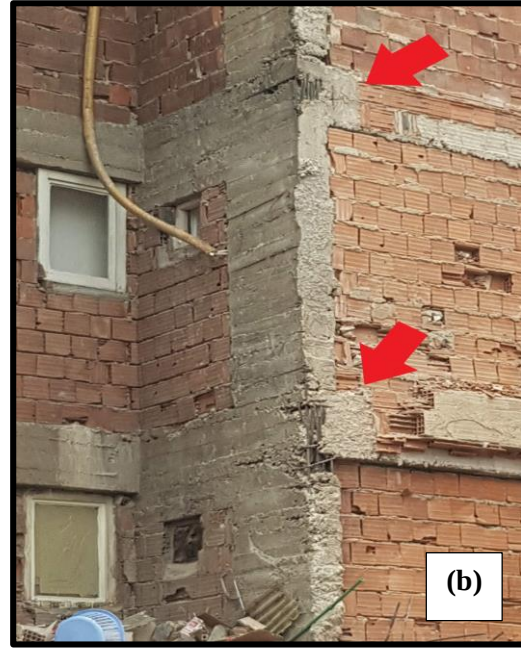
Şekil 4.70 a) Dolgu duvar hasarı, b) Donatısı açıkta olan kolon-kiriş birleşim bölgesi
