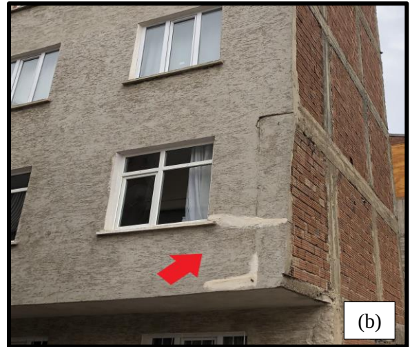
Şekil 4.48 Kapalı çıkma, a) tasarım detayı, b) hasarı
