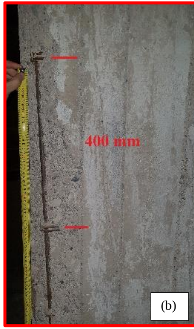
Şekil 4.113 Bodrum kat kolonu ve donatı düzenleme detayları
