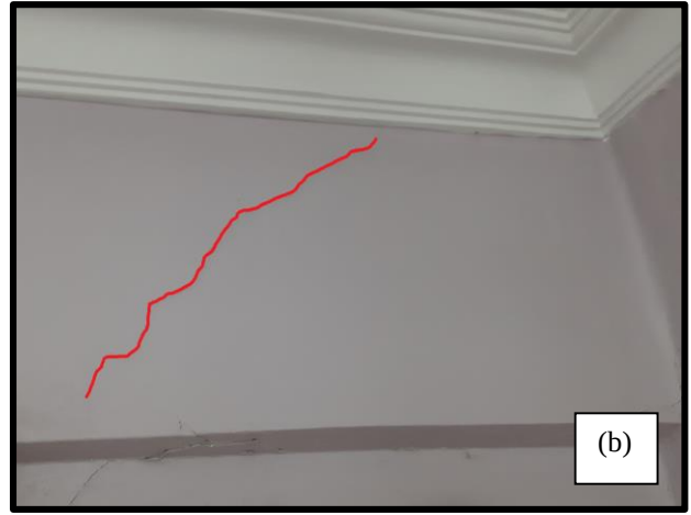
Şekil 4.24 Deprem hasarları, a) dolgu duvar hasarı, b) giriş kesme hasarı
