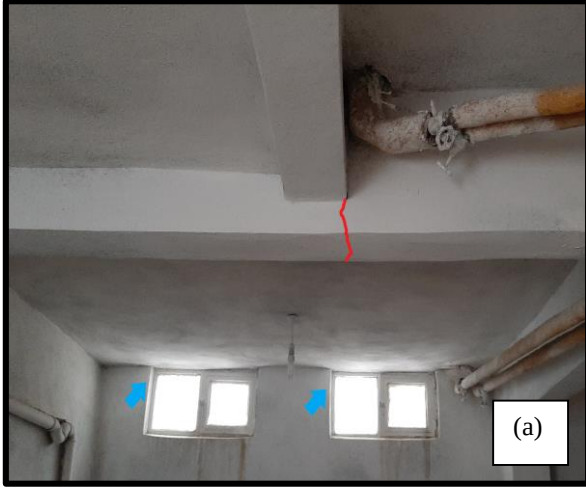
Şekil 4.37 Betonarme kiriş ve döşeme, a) sehim gözlenen döşeme ve hasar gören kiriş, b) tali kiriş ile ana kiriş birleşimi
