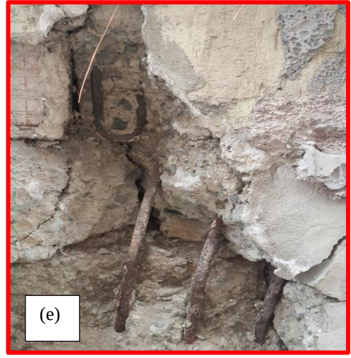
Şekil 4.107 Zemin kat kolon hasarı ve filiz donatısı ile enine donatı detayı
