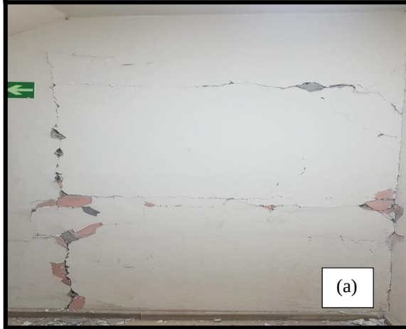
Şekil 4.135 Güçlendirme perdelerinde meydana gelen hasarlar
