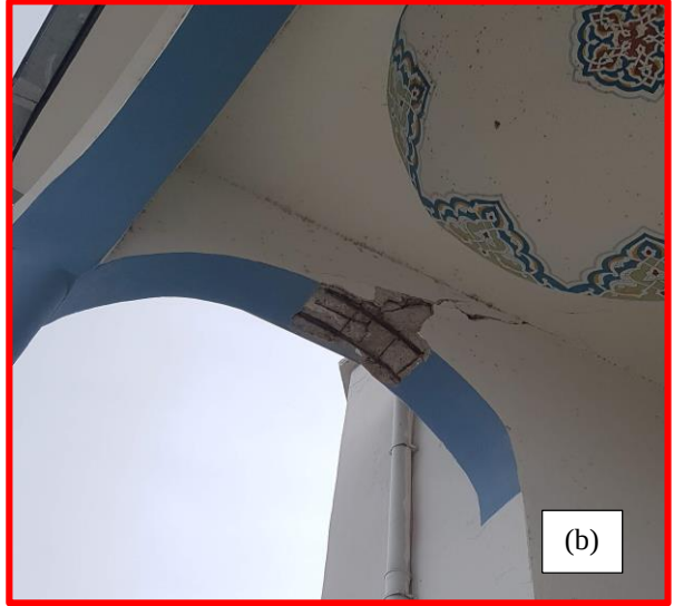
Şekil 4.132 Kemer kirişi ve hasar detayı
