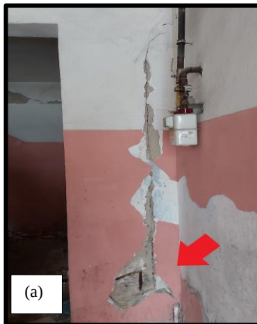
Şekil 4.78 Donatısında korozyon gözlenen kolon
